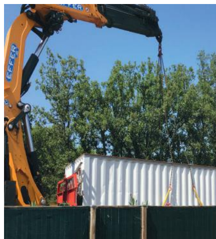
Transport et installation de la piscine en 1/2 journée
